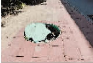
井盖破损露钢筋
