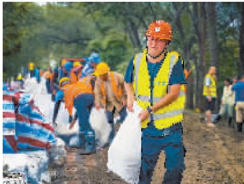
图为市住建委组织抢险人员在大清河右堤老龙湾进行堤防加固作业。
