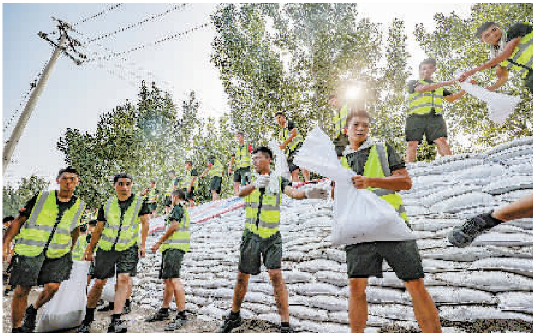
8月10日早晨,武警天津总队近3000名官兵转入巡堤排险。8月3日以来,该总队官兵连续奋战,先后完成大清河、子牙河防堤薄弱段加固任务,固堤11公里,共搬运沙土5.6万余方、9万余吨,给两河防堤垒上沙袋近70万袋。图为战士们列队传递沙袋。
