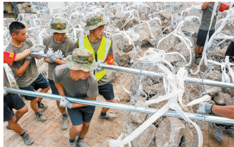
8月11日,82集团军铁军旅战士在台头镇革命桥点位扎了700多个石笼,应对突如其来的管涌。
