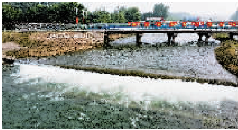
滦河水通过黎河流入于桥水库期间落差达89米,通过98座跌水坝以削减水流势能。 本报记者 周伟摄
