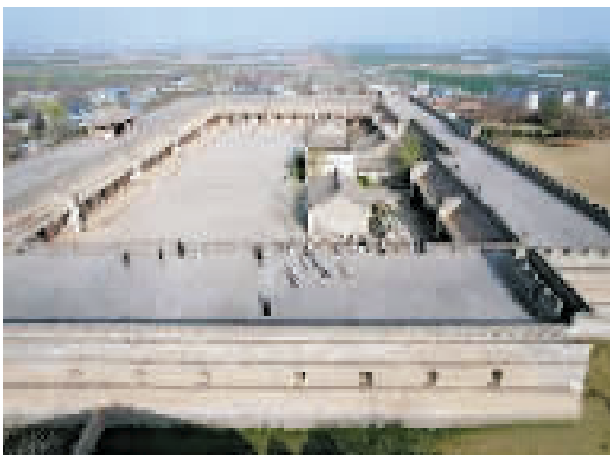
图为位于陕西省大荔县的丰图义仓,建于清光绪八年(1882年),占地面积11039平方米。建筑格局为城中城,分内城和外城,外城坐东朝西,夯土筑城,是义仓防御的第一道防线,内城以仓墙合一的建筑形式构筑,兼具防御和仓储双重功能。慈禧曾御封其为“天下第一仓”。图片来源:央广网
