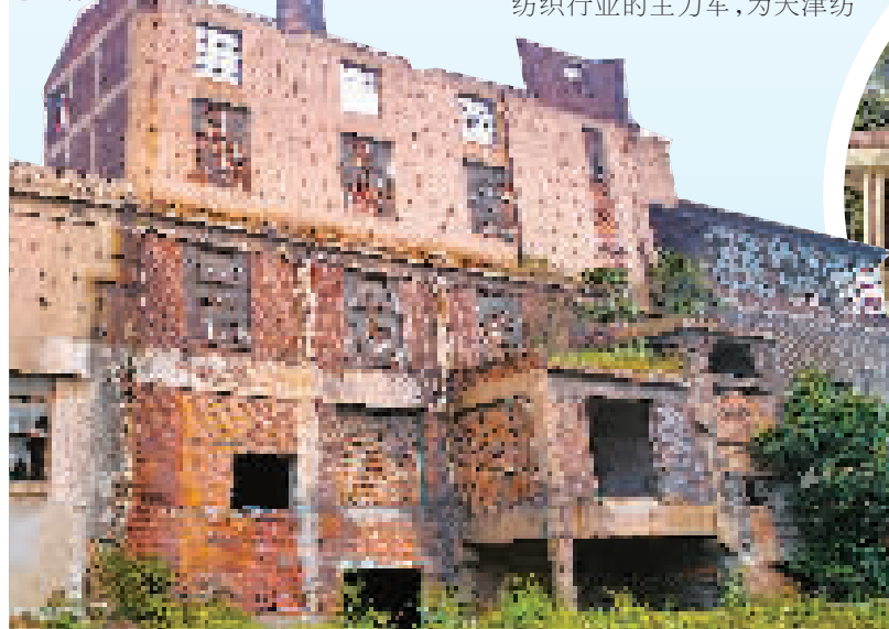
棉三6号楼 老厂房
