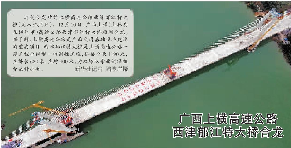
这是合龙后的上横高速公路西津郁江特大桥(无人机照片)。12月10日,广西上横(上林县至横州市)高速公路西津郁江特大桥顺利合龙。据了解,上横高速公路是广西交通基础设施建设的重要项目,西津郁江特大桥是上横高速公路一期工程全线唯一控制性工程,桥梁全长1190米,主桥长680米,主跨400米,为双塔双索面钢混组合梁斜拉桥。新华社记者 陆波岸摄
