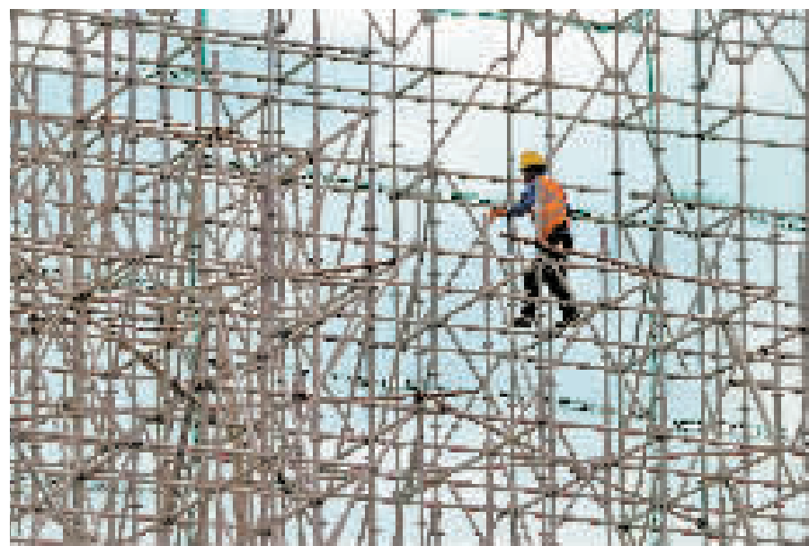
《高空作业》2024年6月14日,天津市津塘立交高架桥修复养护施工现场,工人们在脚手架上熟练作业。 张宝海摄
