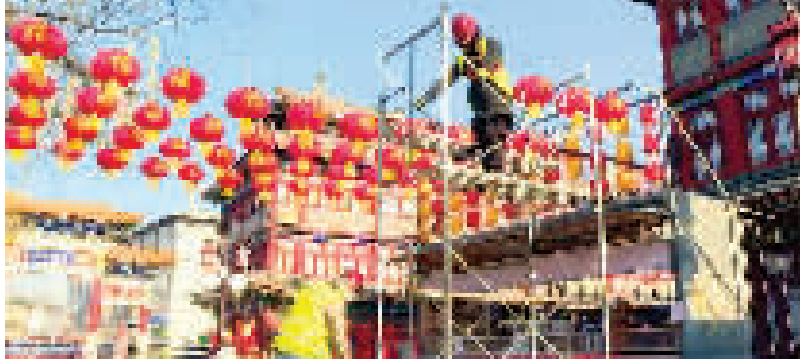
施工现场各项安装与调试作业有条不紊地推进中
