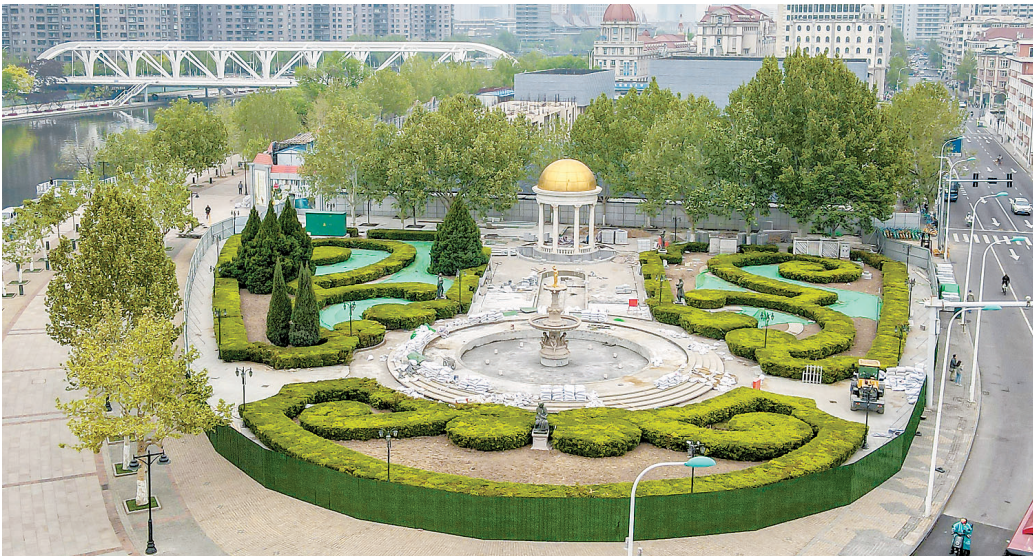
河北区提升改造六处口袋公园,图为正在整修的音乐公园。
