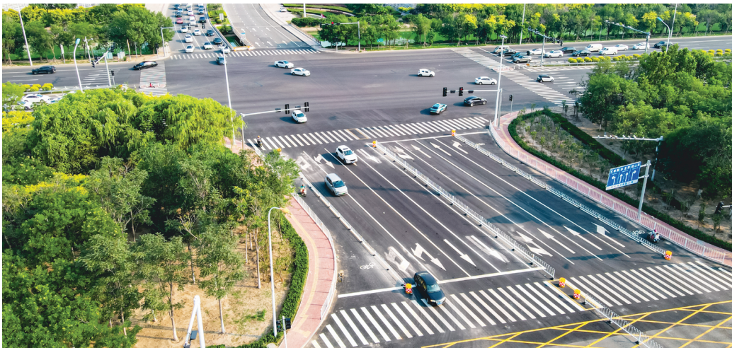
近日,作为津南区双林街道2025年10项民生实事之一的鄱阳路与外环线交口拓宽工程正式竣工通车。
