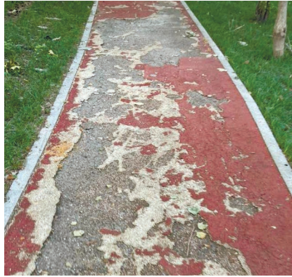
破损的塑胶层
