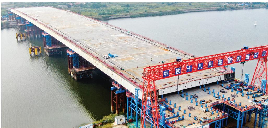
昨日,随着32台大吨位步履式千斤顶协同作业,由中铁十八局承建的滨海新区西中环快速路跨海河桥最后一节钢箱梁稳稳落到设计位置,标志着重达12500吨的主桥钢箱梁顶推就位,工程建设取得重要突破。
