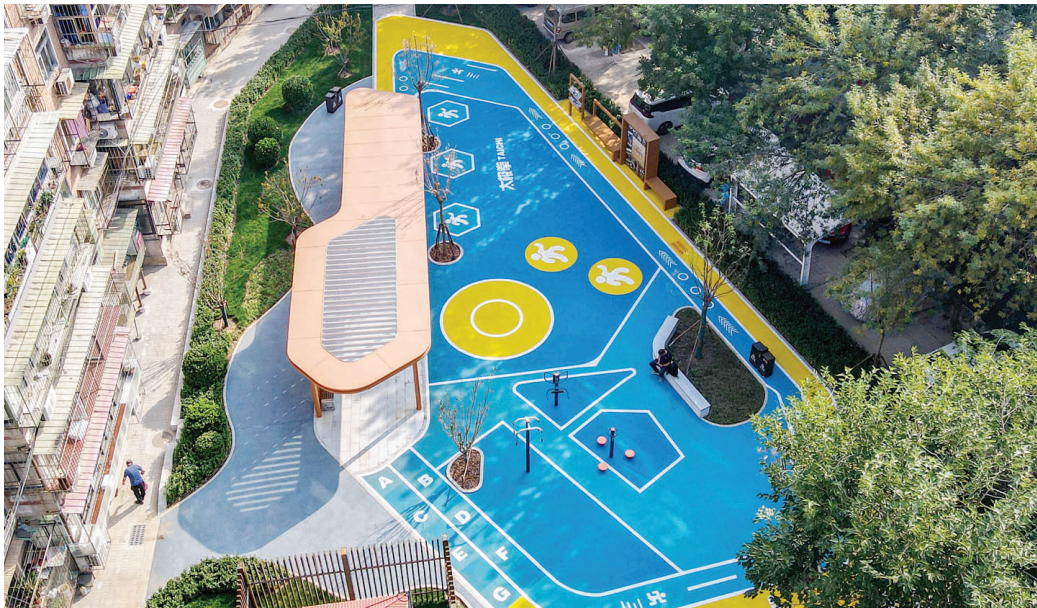
日前,河北区中山北路片区城市更新项目老旧小区改造示范区——舒园里社区花园改造工程完工。
