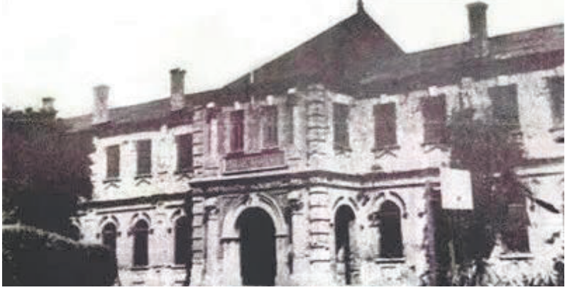
北洋法政专门学堂旧址建筑
