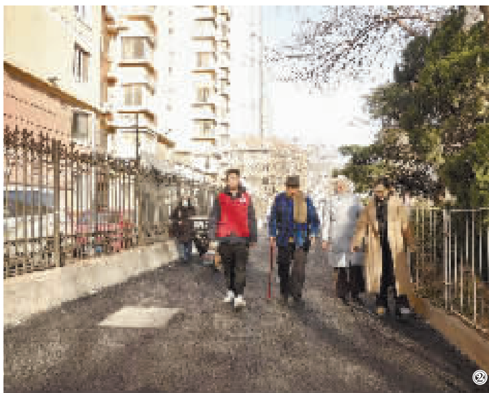
图① 工作人员整修道路 图② 修好的道路焕然一新
