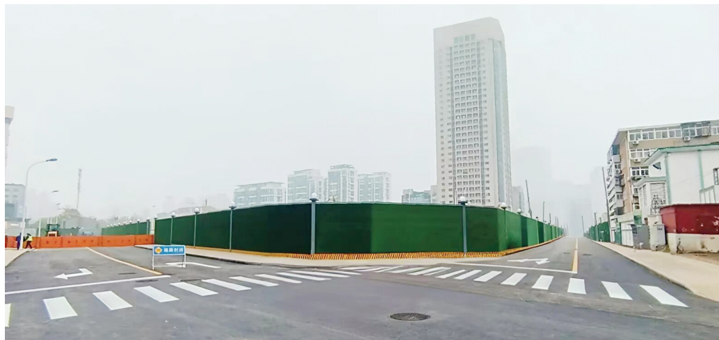
图片由铁建交运天津地铁8号线提供
