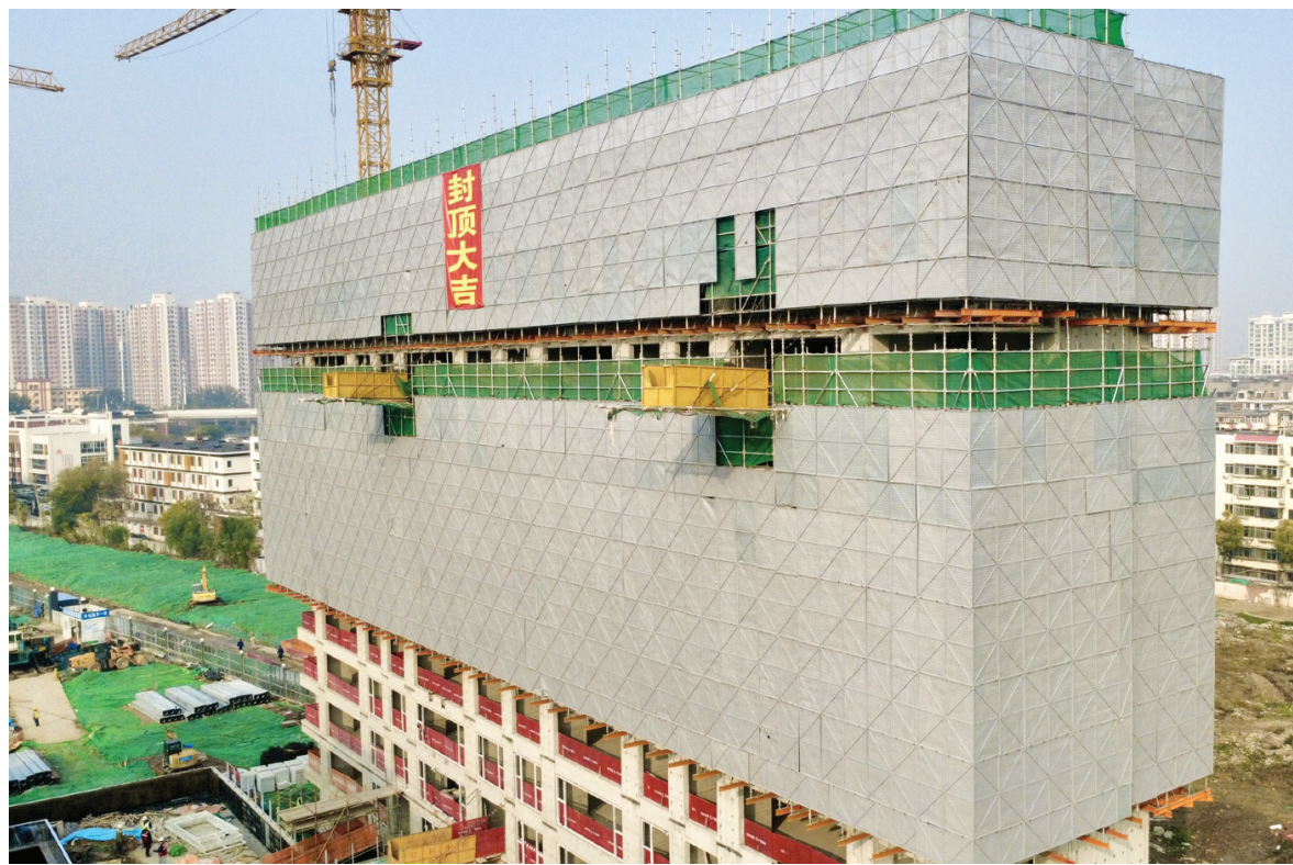
今日,由中铁十八局北京公司承建的河东区成林道(工业大学)2号地城市更新项目首栋住宅楼实现封顶。该项目是本市首批“第四代住宅”,涵盖10座商品房及幼儿园、菜市场等设施。
