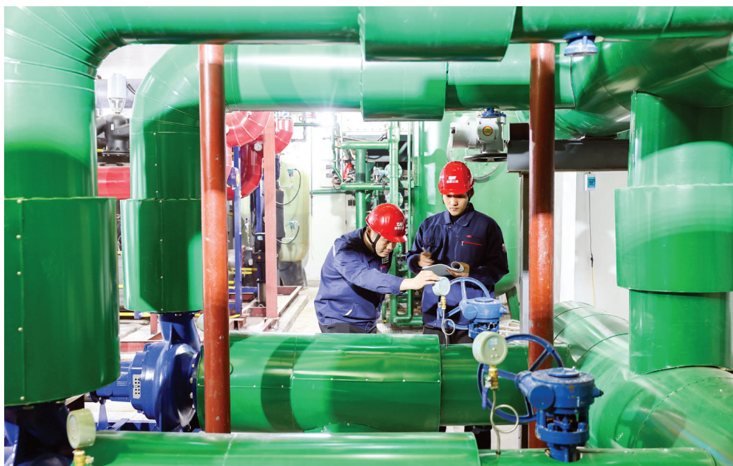
本市正式供热在即,连日来,和平区中环供热站密切观测管网运行情况,并开展管网排气、查漏等相关工作,为正式供热做好准备。
