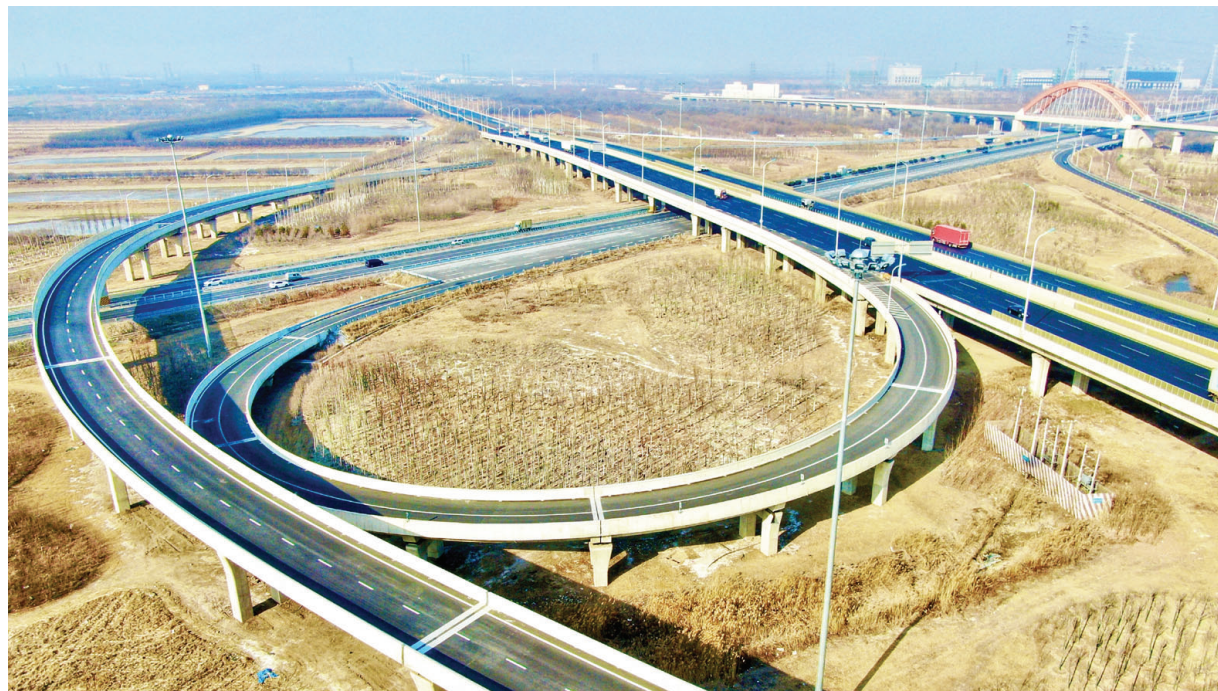
近日,由中国一冶承建的津蓟立交互通工程正式通车,该工程通过新建匝道实现了外环调整线与津蓟快速路的互通连接,市民去往蓟州方向更加便捷。
