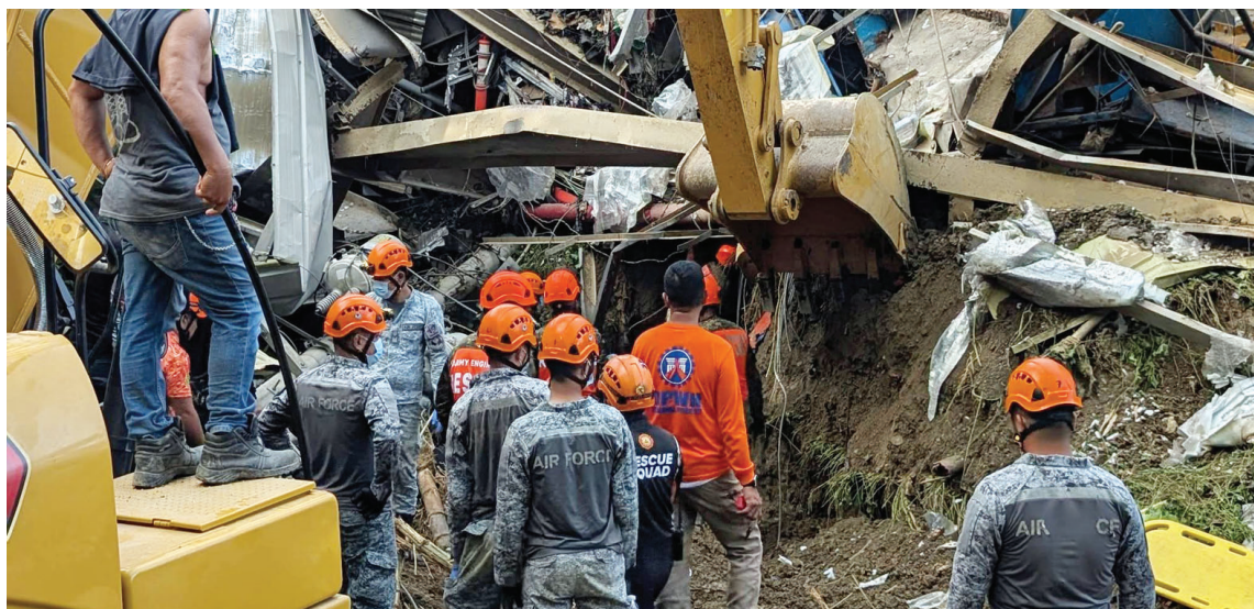
菲律宾中部城市宿务一处垃圾填埋场1月8日因山体滑坡发生塌陷。截至11日,坍塌事故造成的死亡人数已上升至6人。搜救行动仍在继续,目前仍有30多人失踪。 新华社发
