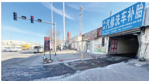
万新街一家洗车店改造前路面被冰层覆盖
