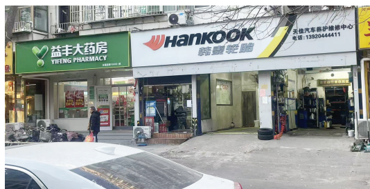
改造后恢复道路原貌
