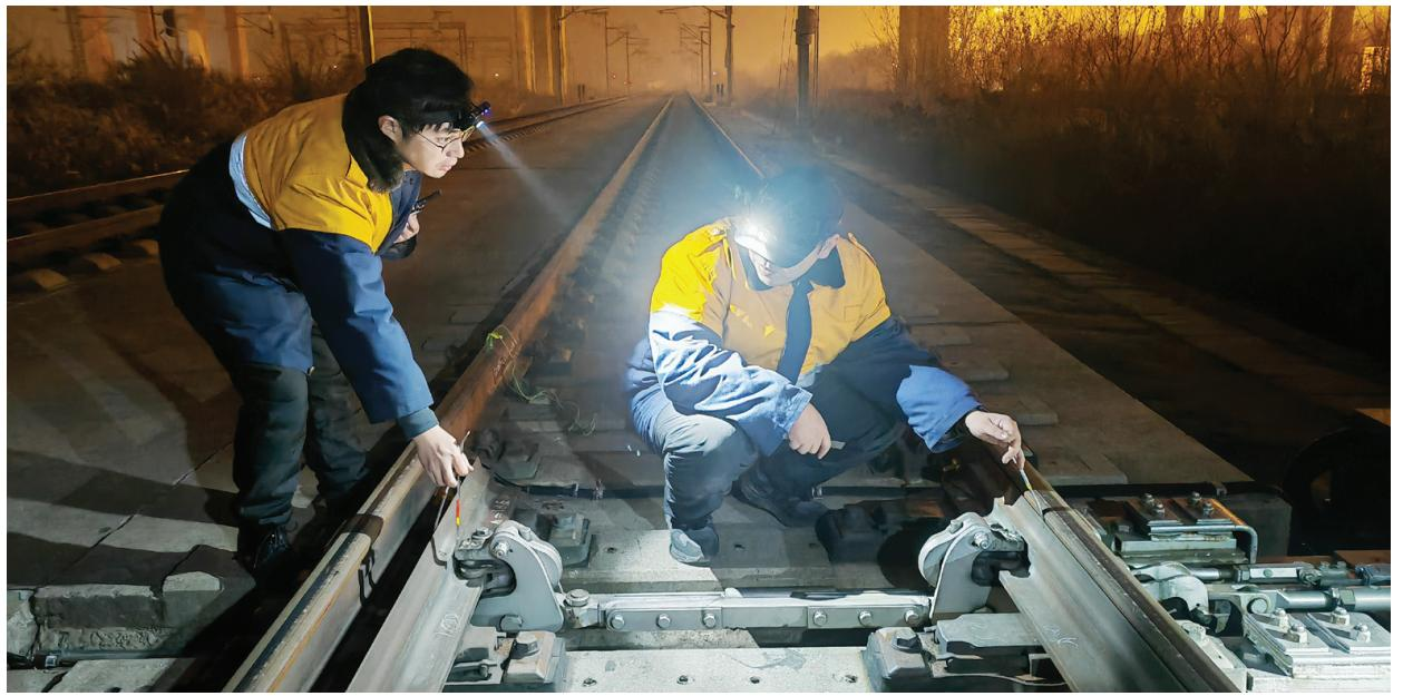
从北京南开往天津的列车,无论是去天津西站还是到天津站,都会在南仓线路上分岔,这里也是一条重要的咽喉通道。天气预报显示,近日津城又将迎来小雪天气。道岔转辙机极易因低温导致关键部位卡阻,一旦发生故障,直接影响道岔设备的机械锁闭功能,进而给行车安全造成隐患。天津电务段京津城际车间南仓线路所工区的靳欣宇和工友们要精准检修道岔各部件,确保极寒天气下设备正常运行。
