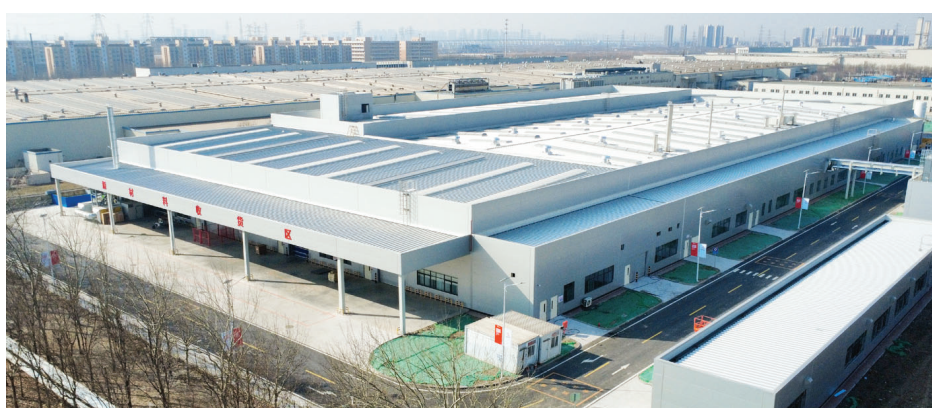
长城汽车新建曼德工厂项目顺利通过竣工验收 摄影 记者 周伟
