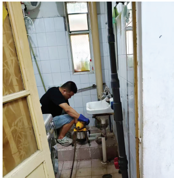
专业师傅疏通管道
