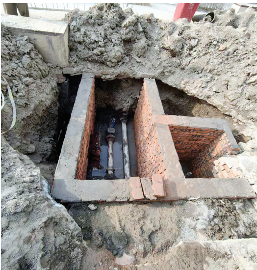
小区内施工现场
