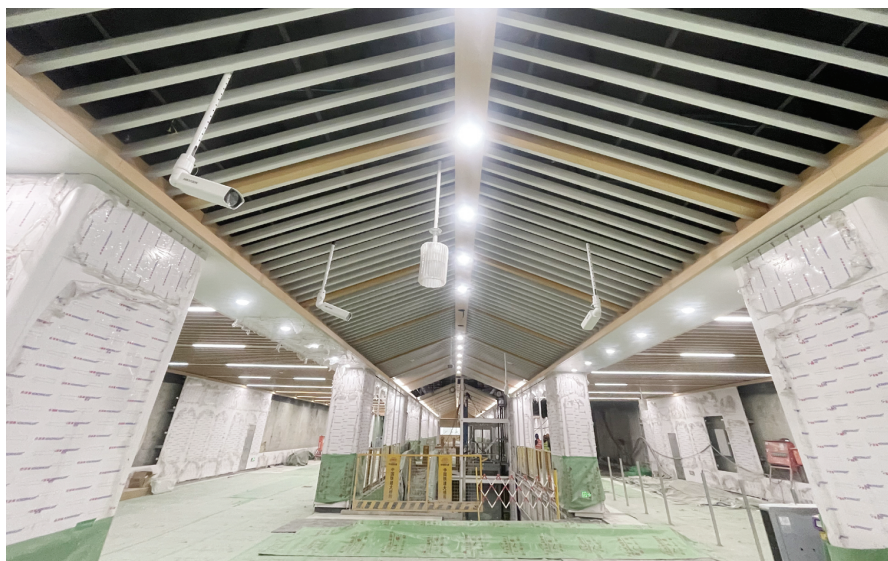
地铁8号线梅江道东站施工现场
