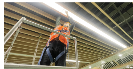
施工人员进行站内装修
