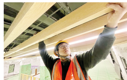
施工人员进行站内装修
