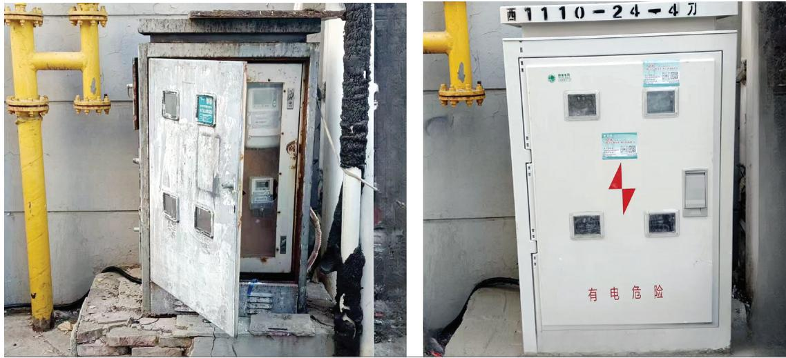
天津市红桥区西沽街道龙禧园第一、第二社区底商周边的电表箱因使用年限较长,普遍存在箱体锈蚀、箱门松动、部件老化等问题,不仅影响环境美观,更因线路裸露带来漏电隐患,直接威胁商户与居民的用电安全。网格员发现群内照片后,立即联系国网天津城西公司红旗供电服务中心负责人房承。房承迅速响应:“我们马上到,请先提醒大家远离现场。”双方随即协作展开全面排查,最终确认共有8个老旧电表箱需要更换。
