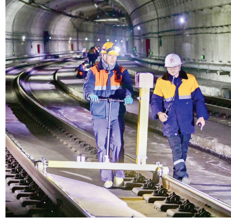
工作人员使用智能设备进行测量
