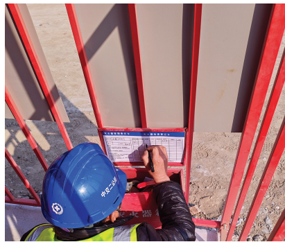
西站西片区城市更新项目现场
