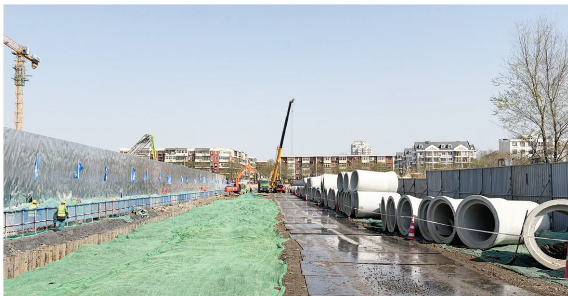
赣州路雨水管道铺设现场
