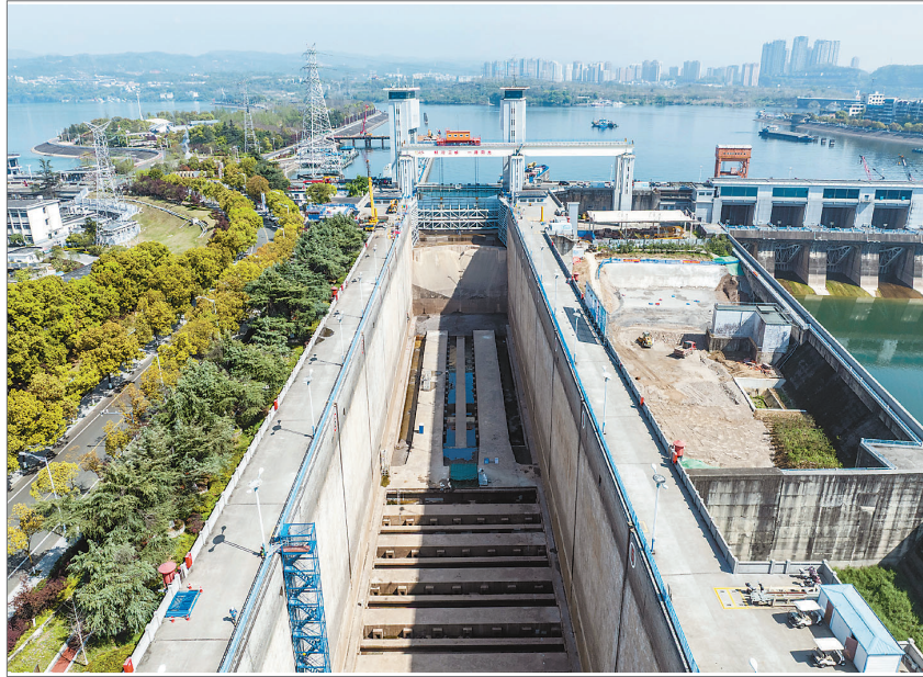
三峡南线船闸、葛洲坝二号船闸于3月4日8时起同步实施计划性停航检修。目前总体进度均已过半,各项施工任务有序推进,检修期间三峡枢纽河段通航运行安全平稳。图为4月1日拍摄的葛洲坝二号船闸停航检修现场(无人机照片)。
