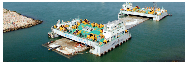
港珠澳大桥沉管浮运安装
