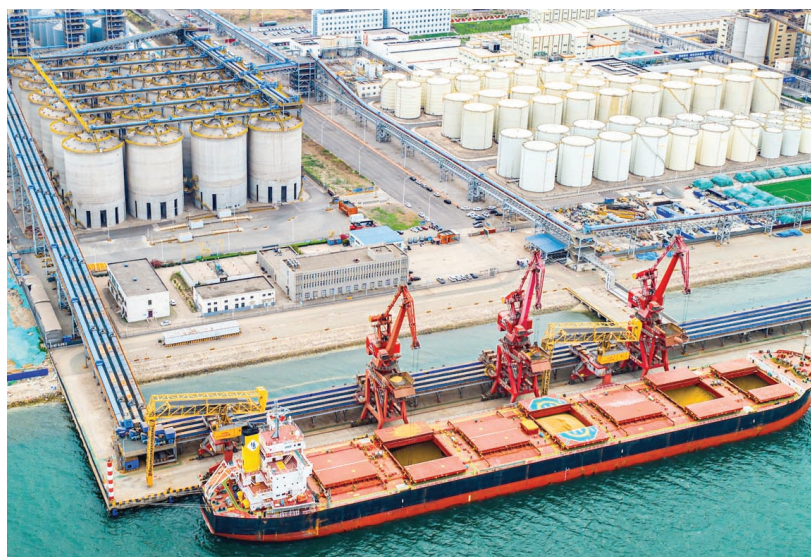
连日来,天津临港现代粮食物流产业园区粮食仓储物流集散中心项目顺利启动了设备带料重载调试和压仓作业,首批进口大豆平稳进入新筒仓,标志着该项目已具备粮食接收、存储、输送等核心功能。 记者 吴迪 摄
