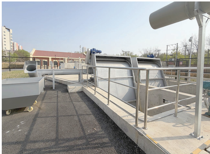
建昌道雨水泵站工程现场
