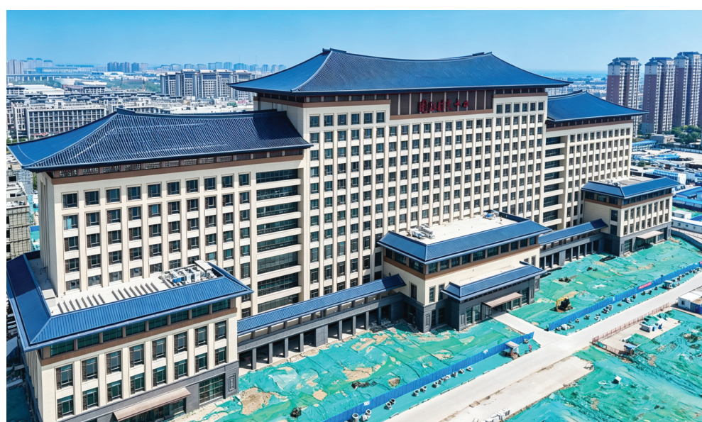
由中建三局承建的天津中医一附院国家医学中心一期工程(国际针灸中心)已基本完工,预计6月具备竣工验收条件。国际针灸中心涵盖针灸博物馆、专业实验室、展览空间及会议交流中心等功能区域,将打造成为针灸学科的重要交流平台。
