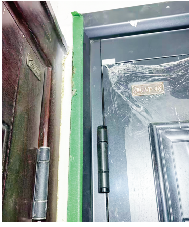
整改后拐角恢复宽度
