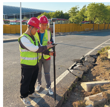
记者姚华(右)在施工现场体验
