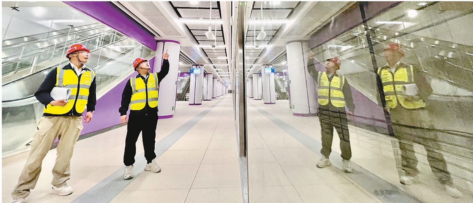
“五一”期间,中铁十八局建设者在地铁8号线下瓦房站进行装饰装修施工。据了解,该站为本市目前在建最深地铁站。
