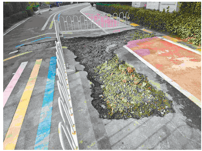
在新城青樾园小区内,平整的路面可见多处频繁破损痕迹。
