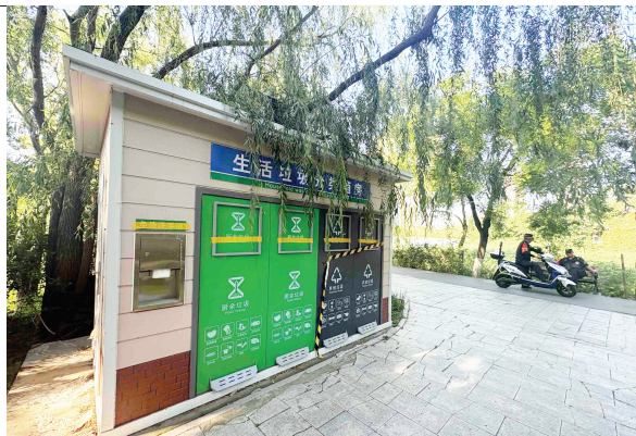
水上公园内垃圾箱房,垃圾投放口被胶带封死。
