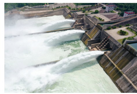
6月22日,小浪底水利枢纽3条排沙洞闸门开启,黄河2026年主汛期前调水调沙随之启动,水库排沙量预计将超1亿吨。
