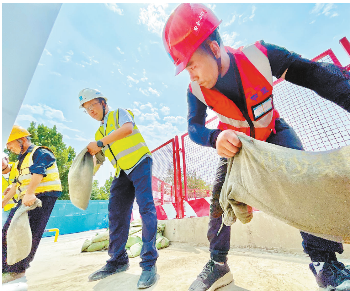
当前,天津正式进入主汛期,防汛备汛工作全面进入临战状态。在东丽区中汽智能网联科技创新基地建设现场,中建三局施工人员做好防汛准备,确保汛期生产安全。图为工作人员搬运沙袋预防积水。
