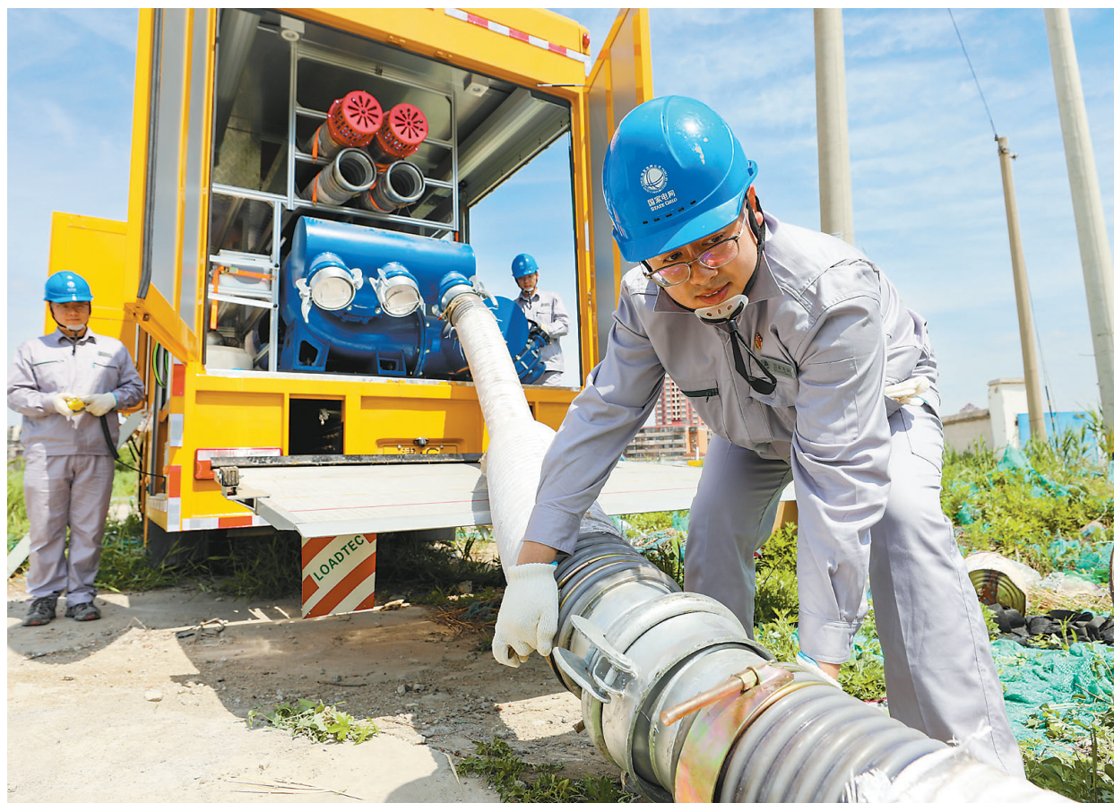
近日,国网天津电缆公司应用应急抢险排水车开展电缆工井排涝应急演练。演练提升人员对专业抢险设备操作熟练程度,确保汛期险情快速响应。该排水车配置真空泵和潜水泵两种水泵,同时定制加长排水管,便于在地下电缆隧道、电缆工井等各类复杂环境中快速排涝使用,保护电网设备汛期安全。
