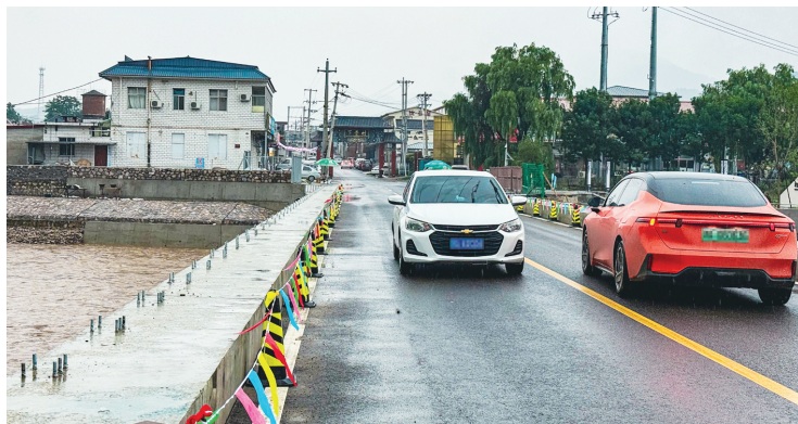
为防止上游漂下的杂物对桥体造成损害，相关部门提前拆除沟河青年桥栏杆，保障安全度汛。 本组摄影 记者 钱进 潘立峰 孙志强
