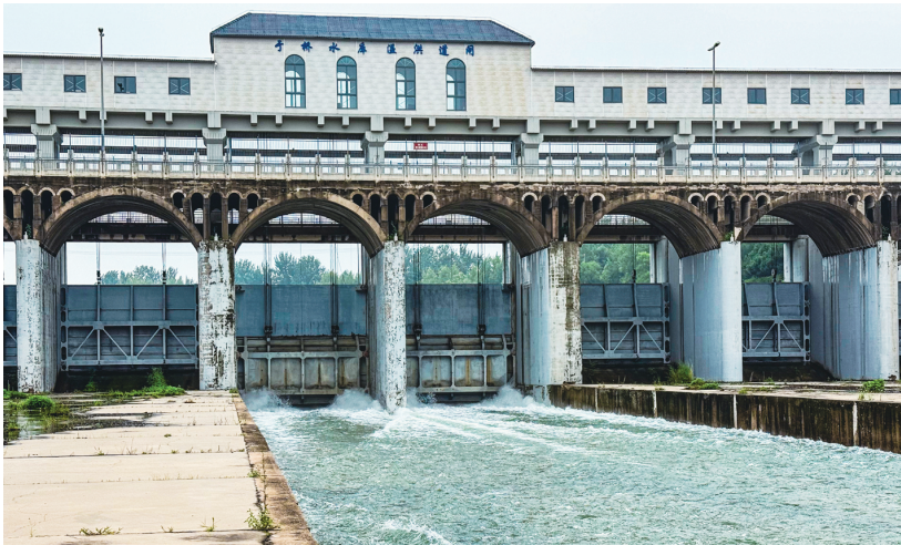
于桥水库溢洪道闸。
