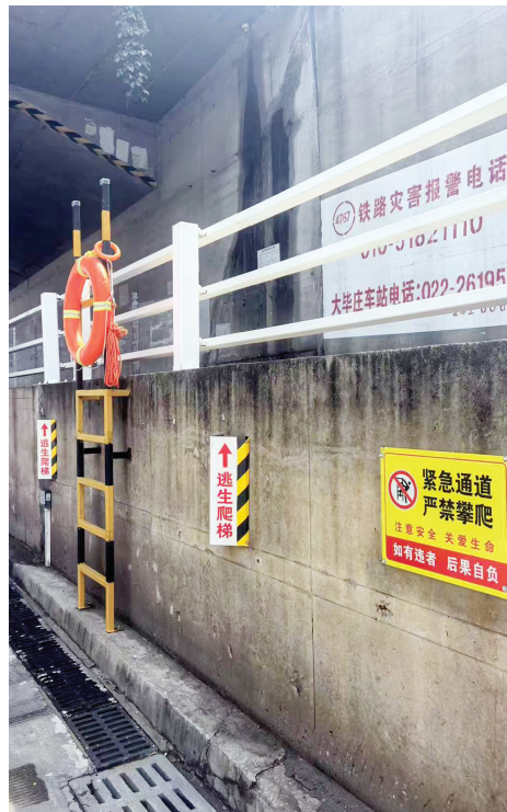
津芦公路大毕庄地道
