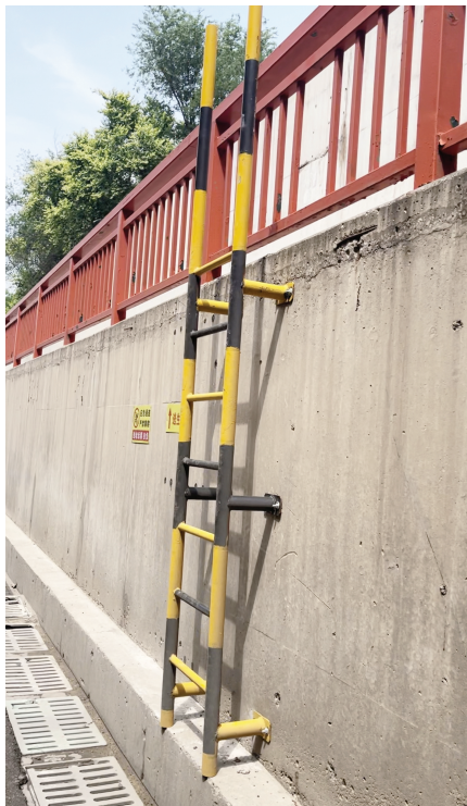
津沽线天津大道地道
