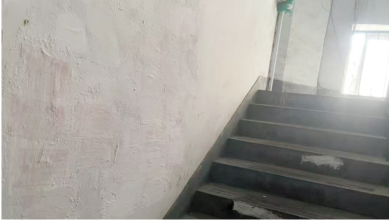
7号楼一楼门内清理过的墙壁
