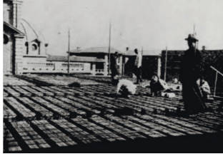
1937届工科建筑系毕业生、留校任教教员张俊德承包工商附中新楼建筑施工现场(1939)
